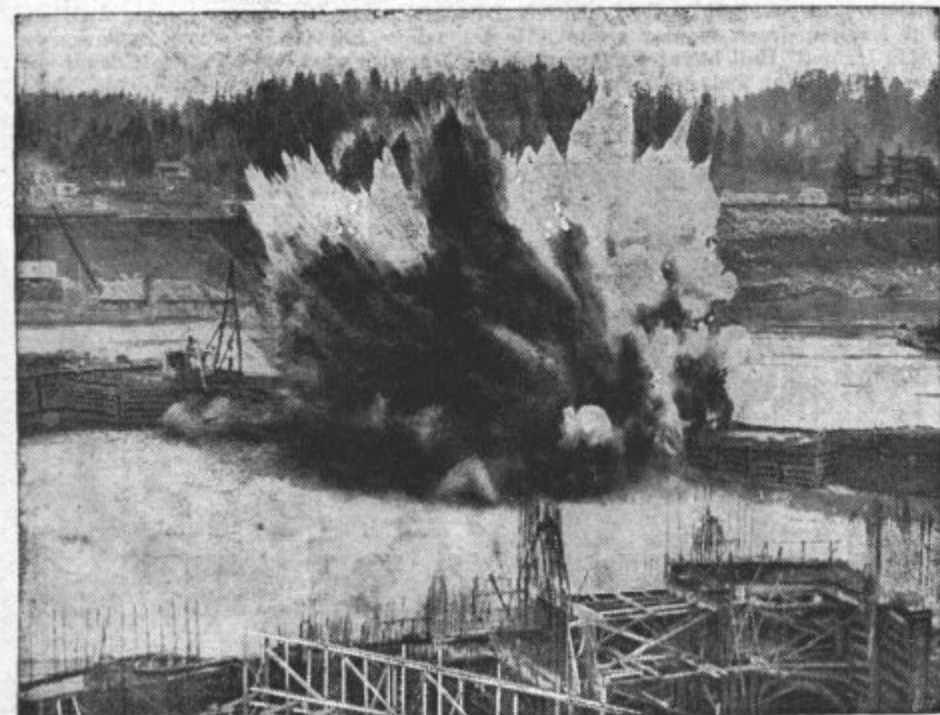
Na reki Kolumbiji v Ameriki razstreljujejo z dinamitom skale za ureditev nove struge.
