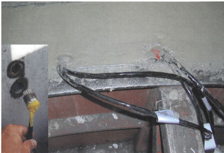
Na manjši sliki levo pripravljena puša za vgradnjo kabla merilnika, na večji sliki vgrajeni merilniki v panel
