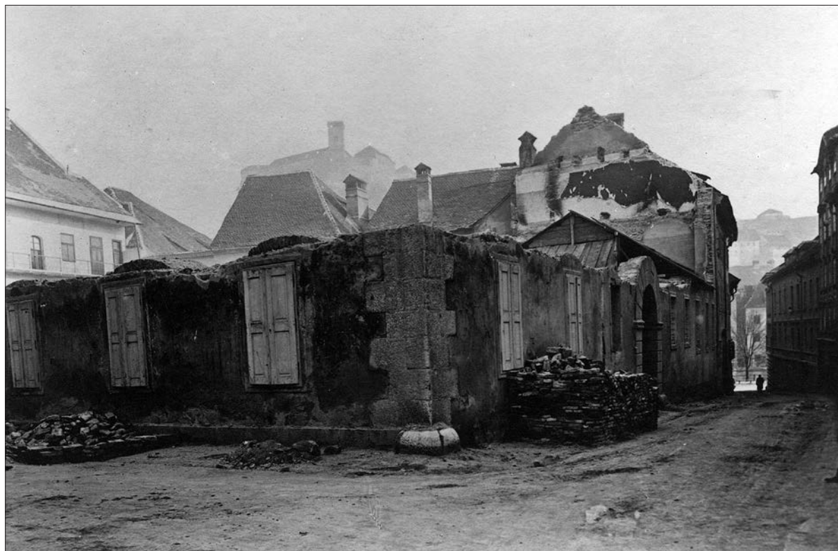
Rušenje ob potresu poškodovane stavbe na križišču Salendrove in Gosposke ulice. Tik za njo je še stala Pogačnikova hiša, v kateri je imel muzej svoje prve prostore (SI ZAL LJU 342, Zbirka fotografij, E16–019; avtor: Wilhelm Helfer, Ljubljana, 1895).
