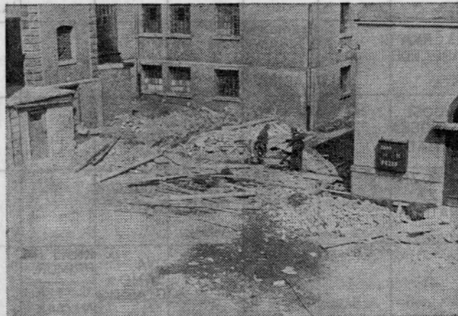
Za čistilnico polagajo nove kable
