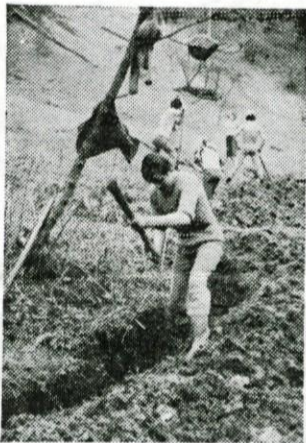
Vaški mladinci pomagajo pri gradnji vodovoda
