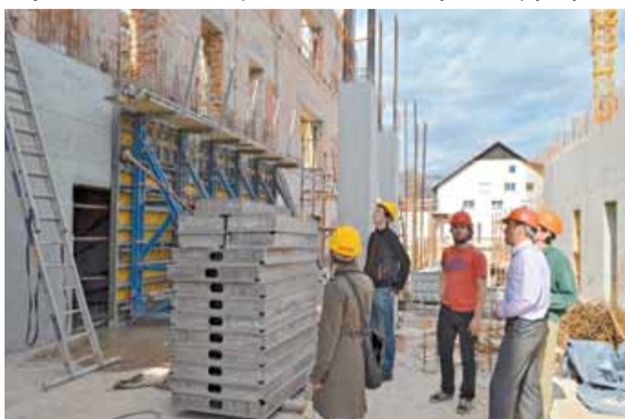
Stare opečne stene šole Toma Brejca so gradbinci obložili z armirano betonskimi stenami ter jih na ta način ojačali. Za člane Skupine Štajn je bilo zelo pomembno srečanje z arhitektom in projektantom na gradbišču, ki sta vsem za boljše razumevanje razložila potek gradbenih del
