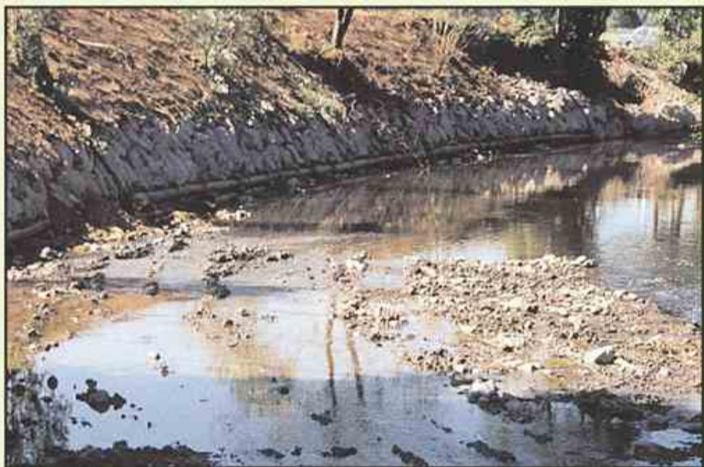
Prejšnji teden so delavci celjskega podjetja Nivo – vodno gospodarstvo uredili le 120 m dolgo brežino na levem delu reke Pake v spodnji Rečici ob Paki. Kdaj bodo lahko uredili še ostalo, pa za zdaj ne ve nihče.
