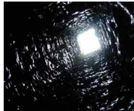
Katranske obloge v dimniku kot posledica zelo slabega zgorevanja zaradi vlažnih drv in nepravilnega kurjenja
