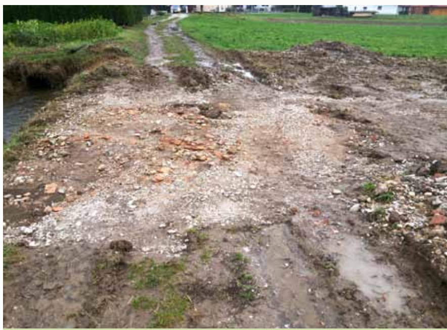
Med intervencijo so prekopaljo cesto in preusmerili vodo na kmetijske površine.
