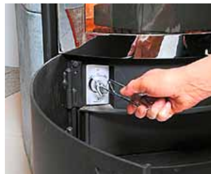
Toplotno moč se določi s količino dodanih polen, le izjemoma z regulacijo zrak (Vir: www.heimwerkerlexikon.selbermachen.de )
