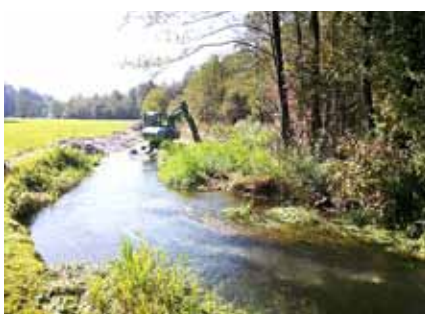
V povprečju je bilo očiščenih približno 3 m 3 po tekočem metru struge.
