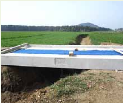
Prefabriciran prepust, zgrajen v letošnjem letu, omogoča neoviran pretok vode v melioracijskem jarku.
