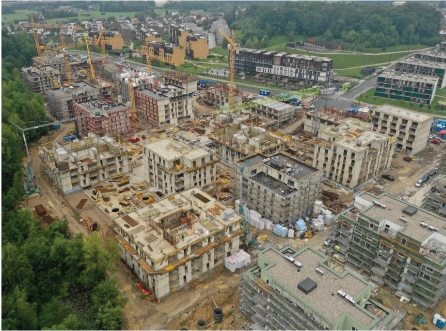
Slika 2. Gradbena dela nadzemni del objektov, avgust 2020. Foto: Matevž Lavrinc
