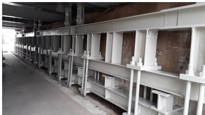
Slika 4a. Novi sistem sidranja v krajni opornik.
