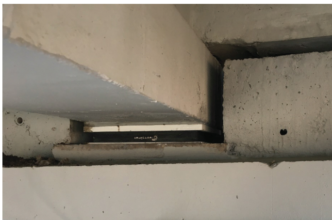
Slika 3. Elastomerno ležišče med stebrom in nosilcem s protipotresnima blokoma na obeh straneh.
