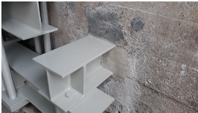
Slika 8. Sidranje v betonski opornik.
