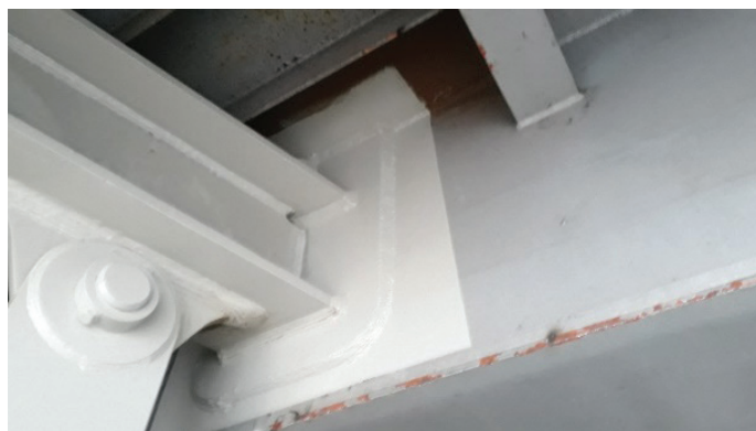
Slika 6. Varjeni priključek vmesnega zvarjenega I-nosilca na stojino glavnega nosilca.
