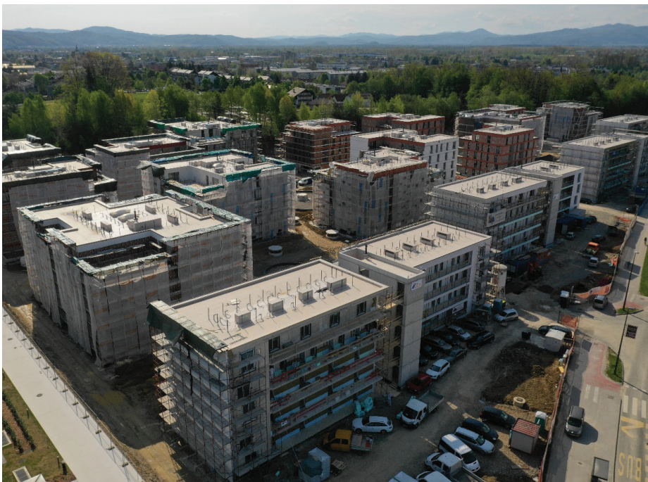
Slika 3. Gradbena dela – nadzemni del objektov, avgust 2021. Foto: Matevž Lavrinc
