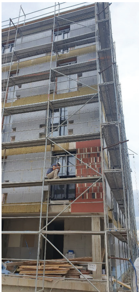
Slika 4. Izvedba izolacije in zaključnega fasadnega sloja, avgust 2020. Foto: Branka Trebušak
