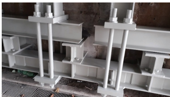
Slika 7. Navojne palice – dva sklopa (vsak štiri palice).
