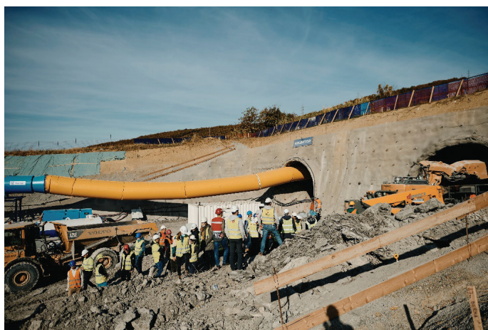
Slika 4. Ekскурzija: ogled gradbišča drugi tir Divača–Koper.
