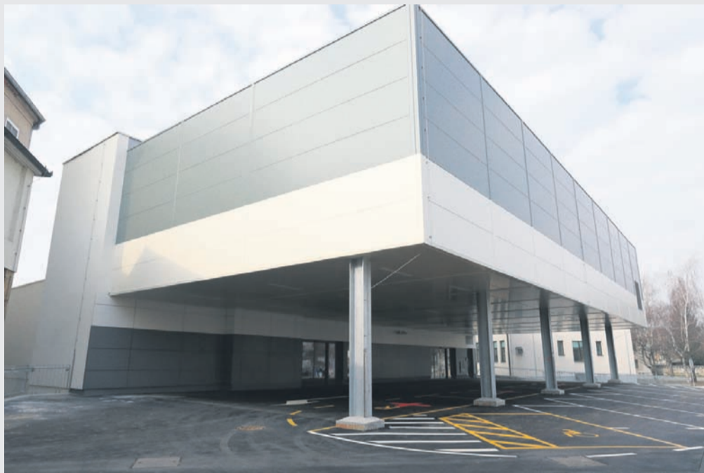
Stavba novega Urgentnega centra v Celju je pripravljena za opremljanje.
