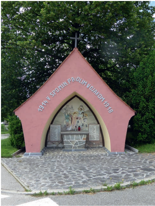
Slika 96: Mislinja, kapela stoji ob cesti Šentilj pod Turjakom–Mislinja. Zgradili so jo okrog leta 1920 (foto: V. Hazler, 22. 6. 2022).
