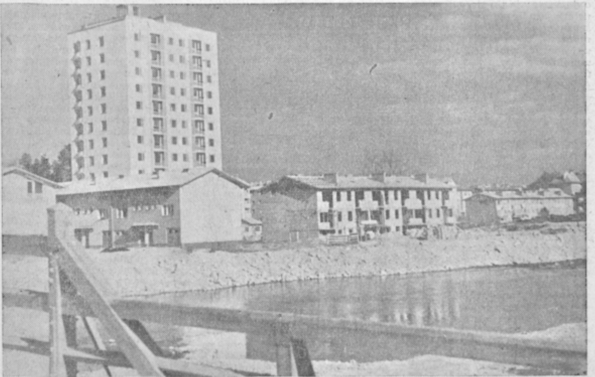
Prvi celjski nebotečnik je že sprejel svoje stanovalce. Vselitev je bila izvršena po določenem vrstnem in časovnem razporedu. V tistih dneh pa ni manjkalo niti neviščnosti. Tako so imeli že prvo »vplavov«, ki je nastala zaradi odprte vodovodne pipe in slabega odтока vode. Škoda je precejšnja. Navzlic temu pa pomeni izročitev prvega celjskega nebotečnika svojemu namenu kar vel k dogodek.
