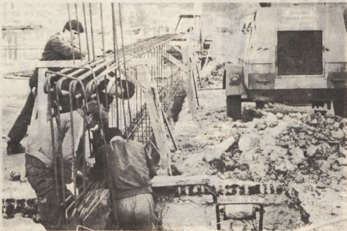
Gradnja temeljev za novi žerjav dobro napreduje
