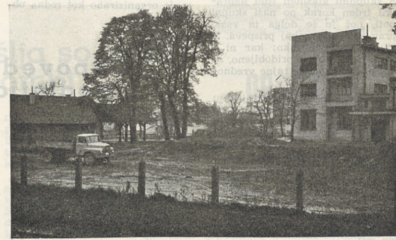
Med železniškim tirom in restavracijo bo stal nov 36-stanovanjski blok. — Na sliki: Z izkopavanjem so začeli 10. novembra 1967
