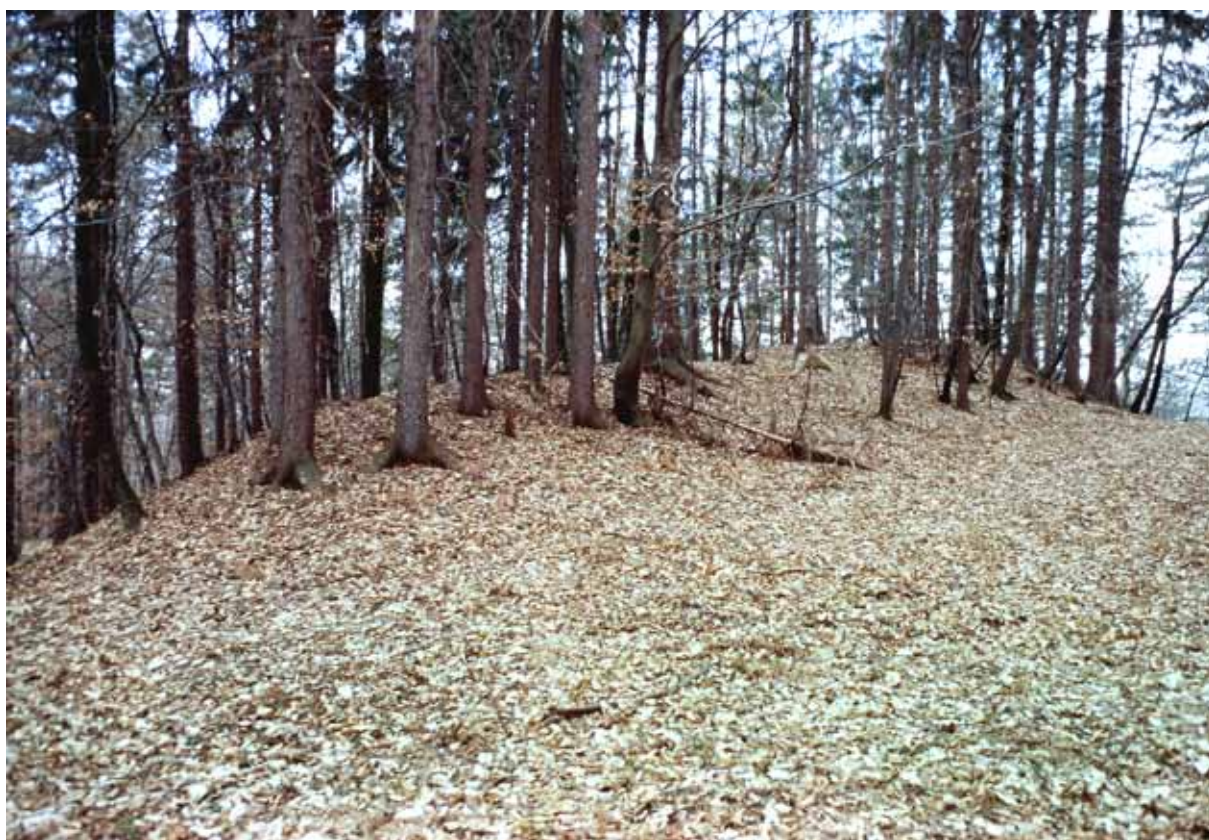
Sl. 173/3: Kočnik nad Segonjami; pogled na oddvojni okop z jugovzhoda. Foto: Janez Dular (2000).
