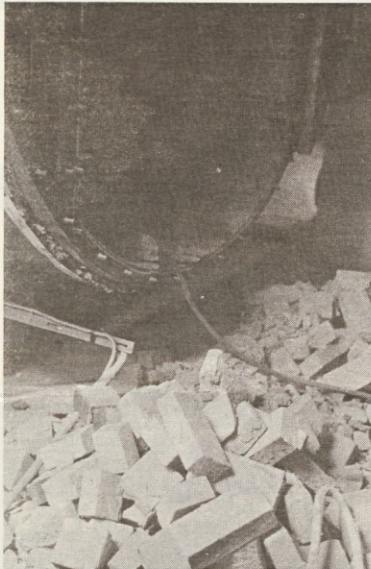
Čiščenje kotla in obnova šamotne obloge
