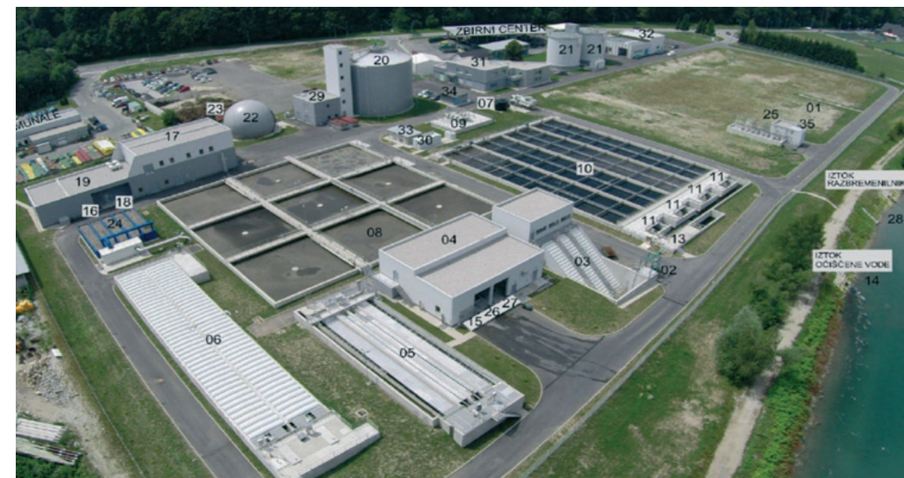
Slika 1: Prikaz tehnoloških sklopov oz. objektov v CČN Kranj
