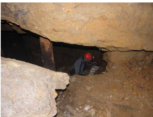
Sl. 4. Delno zarušen Janičekov rov. Vidne so subhorizontalne razpoke vzporedne starejšemu klivažu in strma prelomna površina (zgoraj). Levo spodaj je odlomljen blok brečiranega in nato še močno okremenjenega dolomita. Janičekov rov, opuščen rudnik Remšnik. Foto Z. Žorž.
