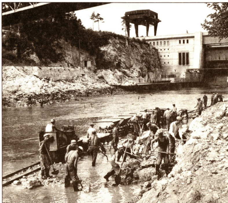
Poglabljanje struge pod elektrarno je bilo zvečine ročno in naporno
