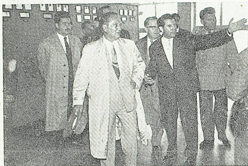
Direktor Pečar razlaga tovarišu Titu in drugim gostom ustroj in funkcioniranje kontrolne transformatorske postaje, kjer posebni aparati sproti nadzorujejo stanje proizvodnosti po vsej tovarni
