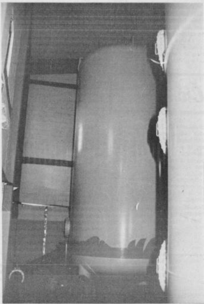
Eden izmed bojlerjev, kjer vodo prečiščujejo s pomočjo ozona
