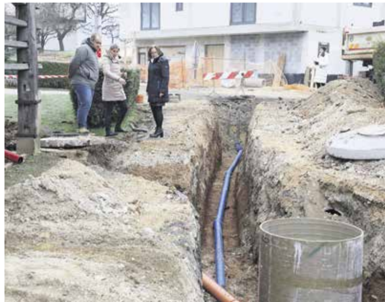
Ogled del na kanalizaciji v Škocjanu
