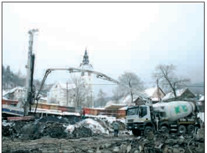
Nad predvideno telovadnico delavci gradijo podporni zid.
