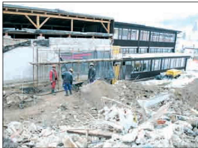
Staro telovadnico, ki je stala za šolo, so podrli. Delavci že pripravljajo teren za gradnjo nove.
