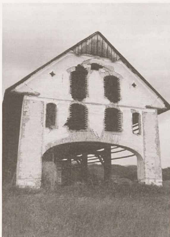
Kozolec pred obnovo, avgust 1999, foto B. Hostnik, fototeka ZVNKD Celje.
