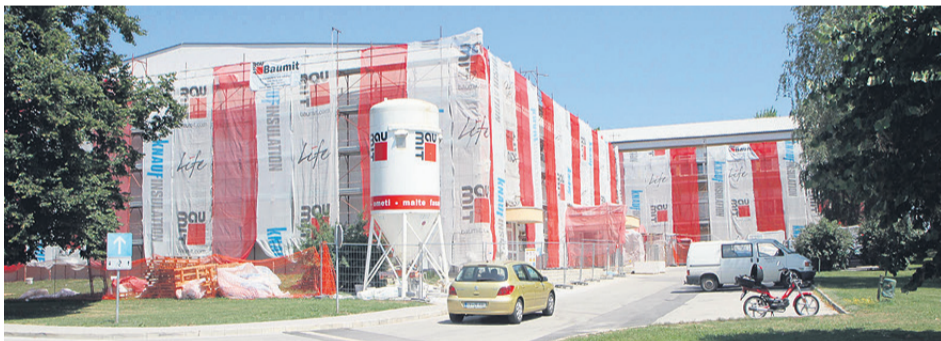
OŠ Šempeter je v teh dneh odeta v rdeče-belo barvo. Za zaščitno folijo delavci obnavljajo fasado, prav tako bodo v sklopu energetske obnove zamenjali del stavbnega pohištva, preuredili kotlovnico in prezračevanje.
