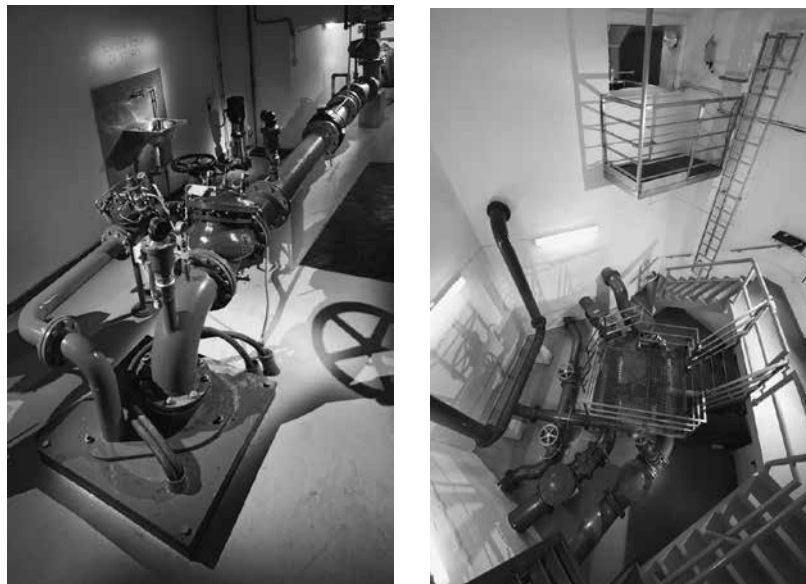
Slika 2: Notranjost vodnjaškega objekta (levo) in armaturna celica vodohrana (desno). Foto: Domen Pal/Branko Čeak/Jože Maček).
