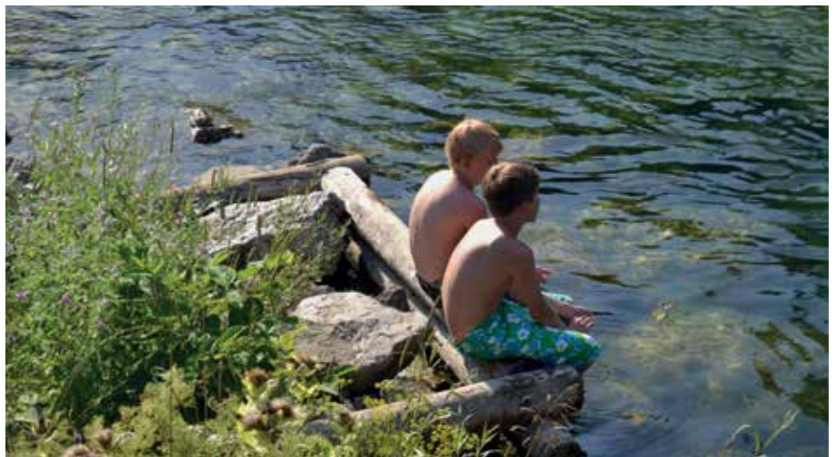
Slika 2: Zavarovanje obrežja s kranjsko steno na Savi Bohinjki. Ureditev je prijazna do vodnega in obvodnega habitata ter privlačna za rekreacijo. (avtor fotografije: M. Bricelj)
