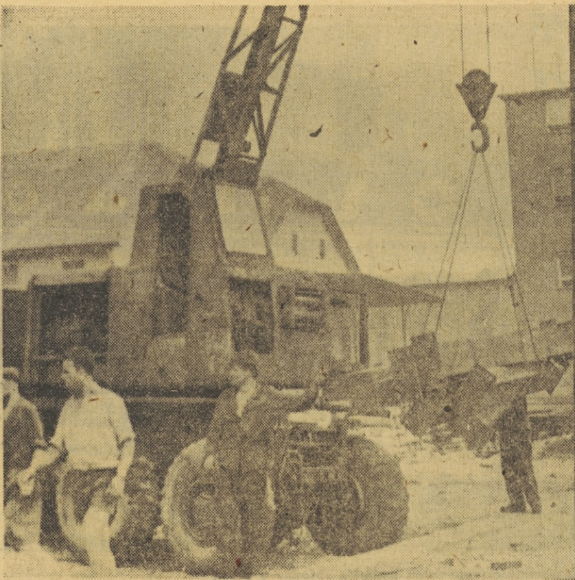
Kovinitehna — nakladanje železnih konstrukcij za gradnjo novih garaž podjetja
