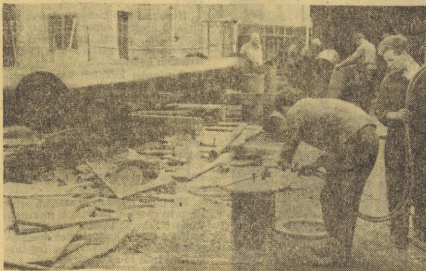
»Plinarna-vodovod« — izdelava kovinastih cevi za novi vodovod Vitanje pri Celju
