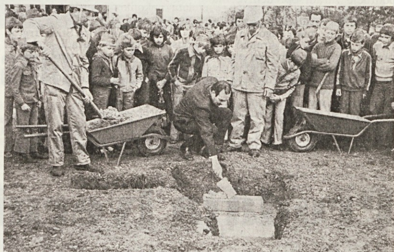
Položen temeljni kamen za izgradnjo novih šolskih prostorov
