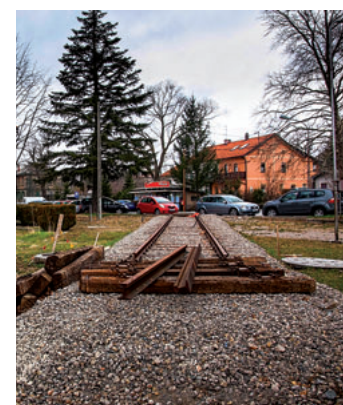
Tir, na katerem bo počivala, je že pripravljen. Streha pa bo tudi kmalu nared.
