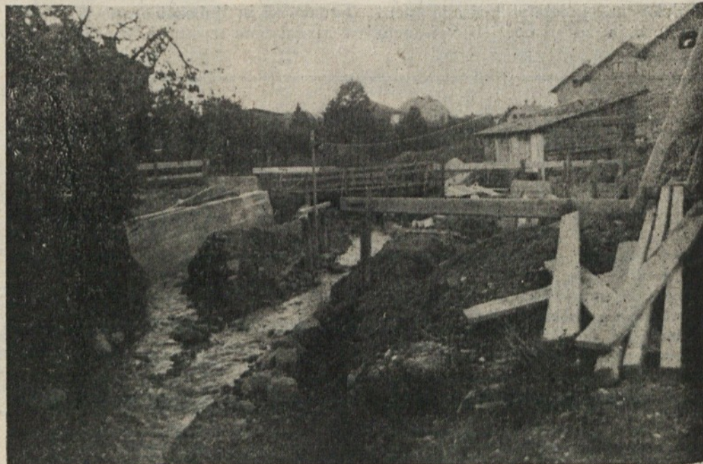
Na Cesti II. v Rožni dolini gradijo nov most. Dela je kar dovolj in upajmo, da bo tudi ta nova pridobitev za Rožnodolce velikega pomena.
