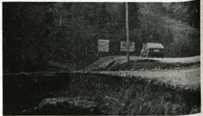
Mulj je na meter visoko zasul spodnjo postajo žičnice, cesto za službena vozila pa je zemeljski usad skoraj odnesel...
