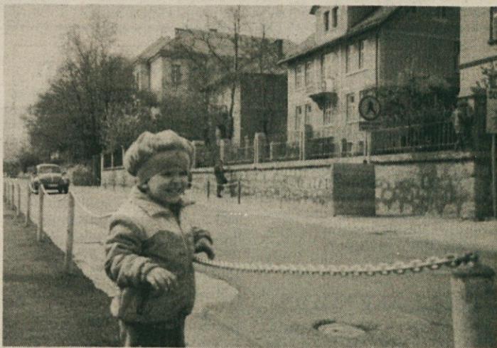
PEŠCE SO ZAVAROVALI PRED PODIRAJOČO SE ŠKARPO - Del Ceste herojev od Ljubljanske banke pa do Koštalove ulice že lep čas čaka na obnovo. Lani so jo delavci Cestnega podjetja preplastili le po sredini, ker pač za kaj več ni bilo denarja. Pred kratkim pa so po naročilu Republiške skupnosti za ceste zavarovali obe strani pločnika, na strani pod gimnazijo in osnovno šolo pa so prehod za pešce celo zaprli z lesenimi plankami, da bi mimoidoče pešce obvarovali pred nevarnostjo krušenja škarpe. Vodja gradbene operative v sektorju za vzdrževanje pri Cestnem podjetju Rudi Ahlin je povedal, da so zaenkrat dobili le naročilo, da cesto zavarujejo. V kratkem naj bi ta odsek začeli tudi obnavljati, vendar, kdaj točno se bo to zgodilo, ni znal povedati. (Foto: J. Dornič)
