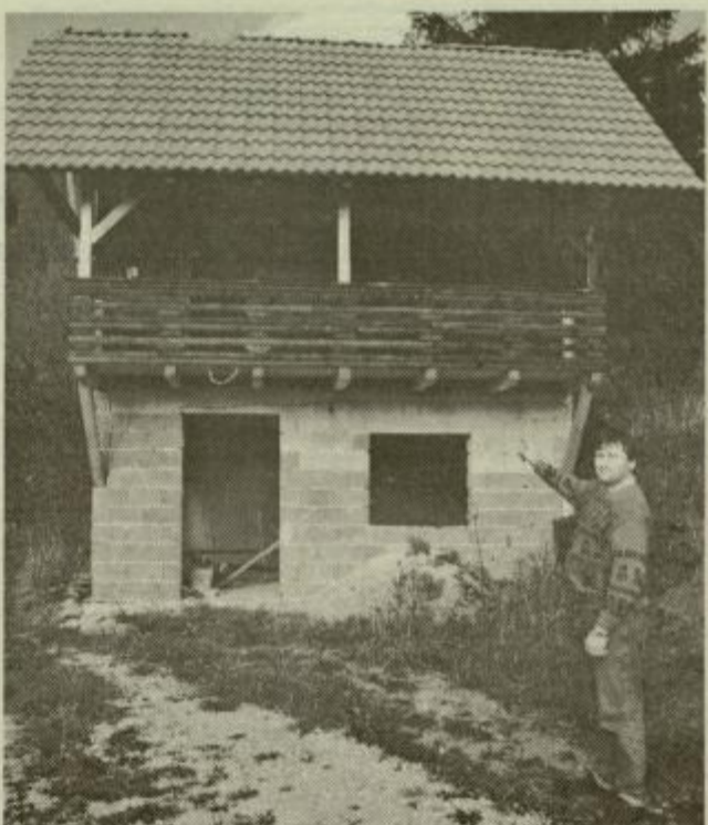
Alojz Hriberšek ob objektu v Belih Vodah, predvidenem za rušenje.
