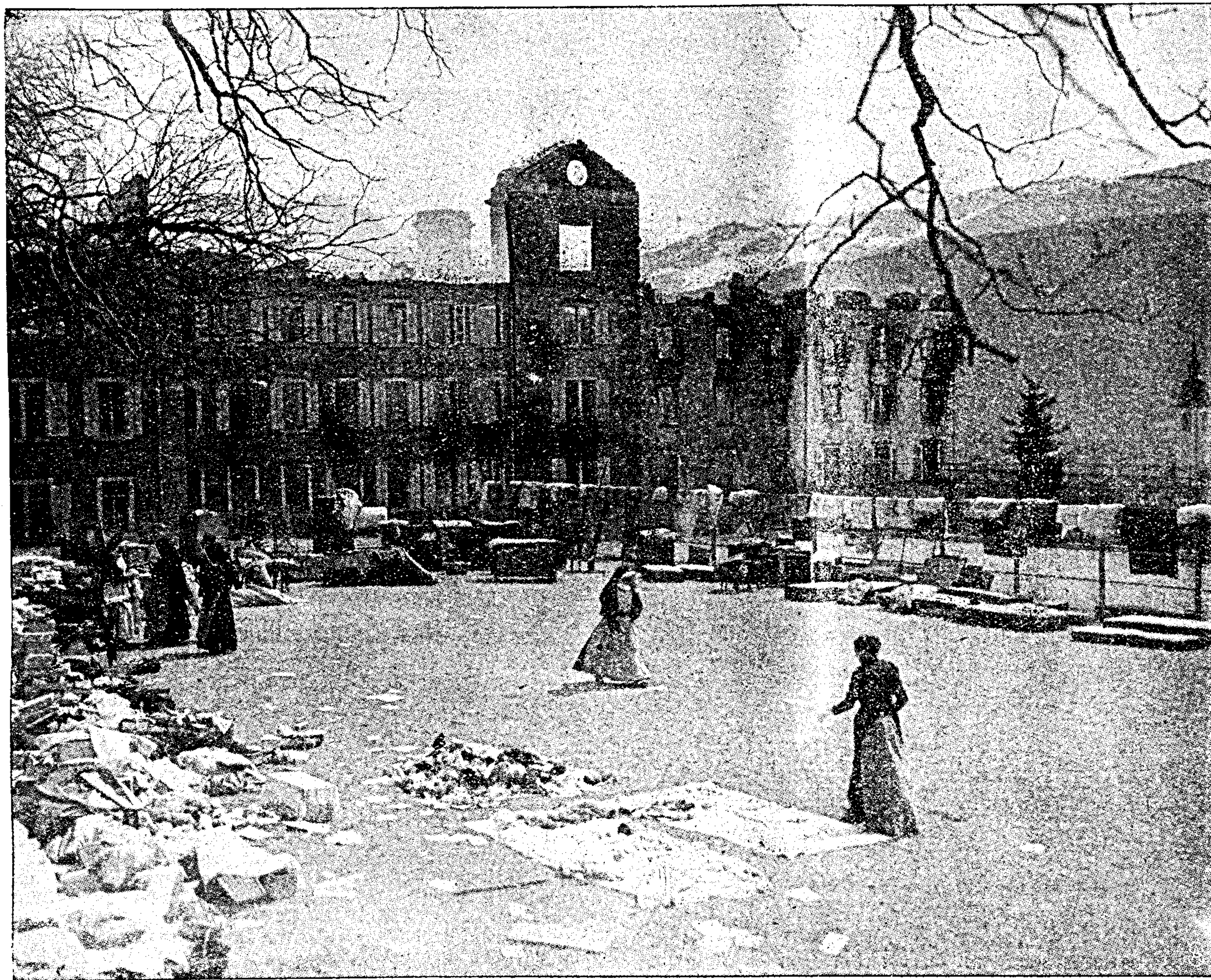
Der Brand des Kollegiums Mariastift in Schwyz. Das zerstörte Gebäude nach der Feuerbrunst.
