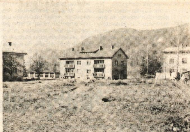
V Mostah cesta poteka skozi stanovanjsko območje v pokritem vkopu (galeriji). Na tem delu bo treba podreti tudi stanovanjski blok (na sliki)...
