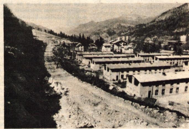
Na območju Podmežaklje se cesta "prebija" skozi pobočje nad stanovanjskim delom...
