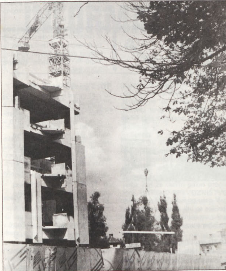
Gradbeni žerjav je pravkar dvignil montažno fasadno ploščo ob stavbi banke v Novem mestu
