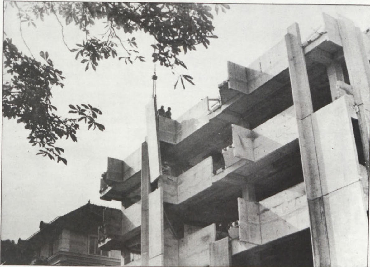
Montaža fasadne ploče na stavbi banke v Novem mestu
