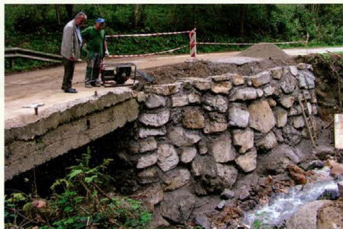
Sanacija občinske ceste po neurju leta 2014
