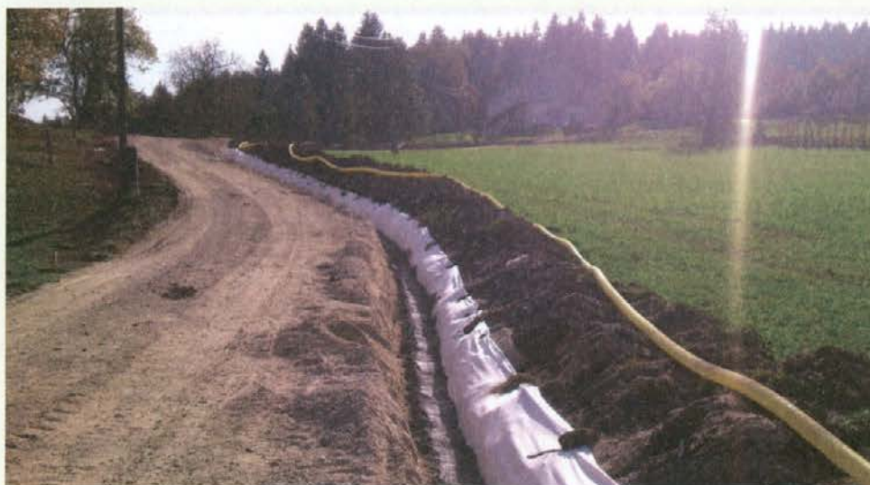
Začetek del rekonstrukcije lokalne ceste Sele-Poštarski dom
