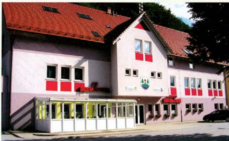
Nova večnamenska stavba v Podvelki
