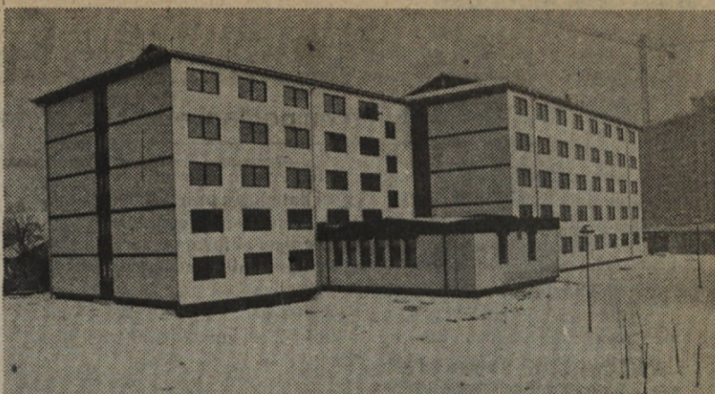
Gradisov novi samski dom v Fužinah, tokrat posnet z zadnje strani. Objekt je gradbeno dokončan, okrog novega leta napovedana vselitev pa se je spet zavlekla za kakšna dva meseca, ker nam še ni uspelo dobaviti in instalirati vse potrebne opreme. Foto: G. B.
