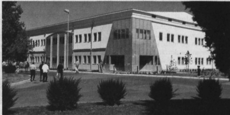
Zgradba strokovnega usposabljanja
