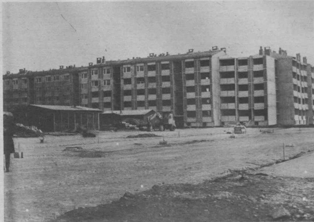
PRVI STANOVALCI ŽE VSELJENI — Lanska izredno mila zima je omogočila gradbenikom, da so lahko brez zastojev in brez običajnih „zimskih počitnic“ nadaljevali z gradnjo novega Štepanjskega naselja. Tudi letošnja zima jim gre izredno na roke in lahko pričakujemo vselitve nekoliko prej kot sicer. Sploh pa so se prvi stanovanjci že vselili. Več o tem boste lahko brali v naslednji številki Naše skupnosti. Na sliki: Stanovanjski blok, ki je že vseljen in blok, ki čaka na vselitve pomladi.
