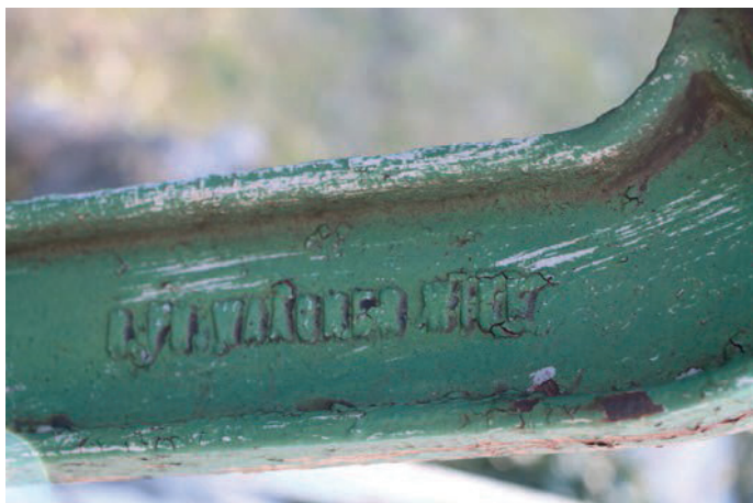
Slika 13. Na stebričkih Wagnerjeve ograje na Solkanskem mostu je še vedno dokaj dobro vidna signatura proizvajalca, stebriček je zasukan vodoravno, foto: Gorazd Humar [Humar, 2022b].
