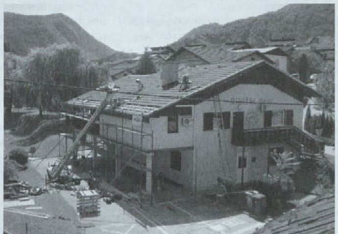
Ribiški dom je dobil novo streho.
