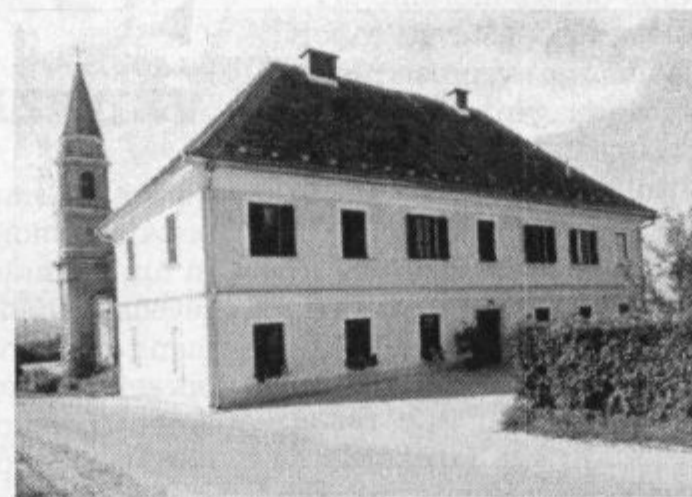
Župnijski dom v Teharju pri Celju. S HYDROMENT OMETOM sanirana zgradba.
