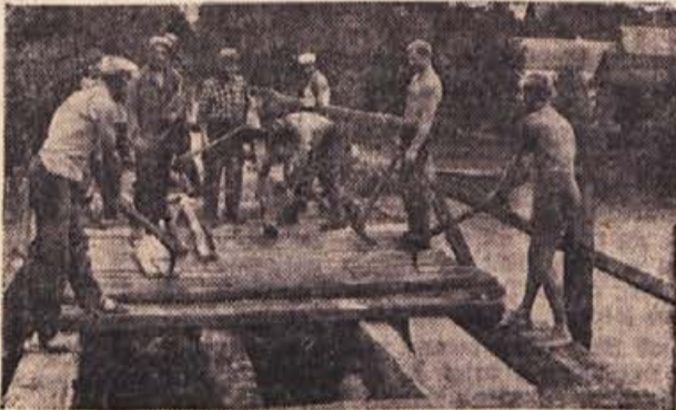
Prebivalci so pri obnovi mostu na Borštu pomagali s prostovoljnimi delom
