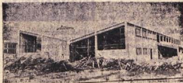
Novo stavba Novolesovega obrata drobnega polistva je ob tovarni vezanih plošč v Straži zrasla skoraj čez noč.
