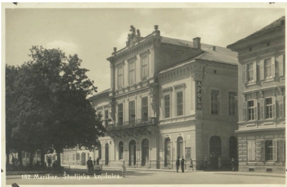
Slika 3: Pročelje stavbe SNG Maribor okrog leta 1929. V njej sta delovali Študijska knjižnica (1921–1941) in Ljudska univerza (1922–1941, 1945–1950). 16
