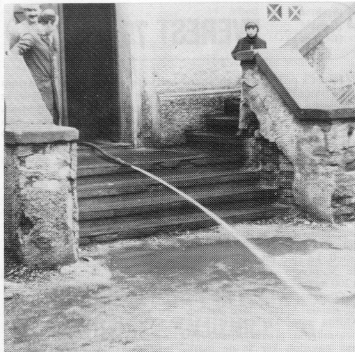
Predsednik in poveljnik IGD BPT sta preizkusila delovanje hišnega hidranta in ugotovila, da je bil le ta v času požara usposobljen za aktiviranje, toda nihče se ga ni poslužil
