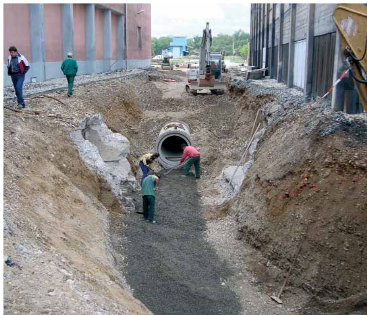
Gradbišče med elektrolizo B in usmerjevalnico
