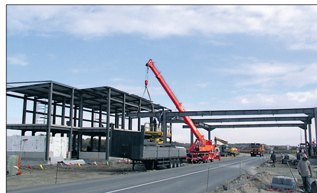
Mejni prehod Središče ob Dravi se gradi s polno paro; v zadnjih nekaj tednih je na gradbišču že videti, kako bo izgledal prehod.
