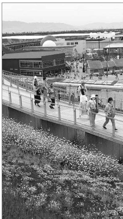
Slika 4: Veliki obroč (ang. Grand ring ) je krožna lesena konstrukcija, zgrajena z uporabo tradicionalnih japonskih tehnik gradnje z lesom. S svojimi 20 metri v višino in obsegom približno 2 kilometra je zasnovana po zamisli japonskega arhitekta Souja Fujimota. Simbolizira koncept enotnosti v raznolikosti, obiskovalcem pa ponuja sprehajalno pot z razgledi na razstavišče, morje in mesto, obdano s cvetličnimi gredicami in parkovnimi ureditvami (foto: Matej Nikšič).
