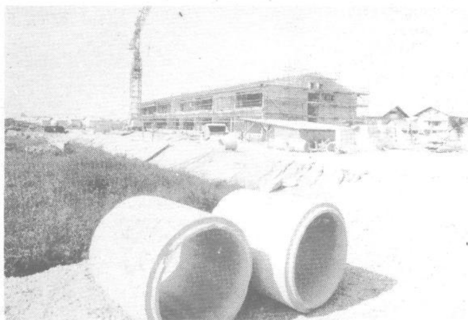
Pogled na gradnjo šole in vrta Krim Rudnik
